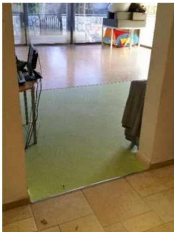
Accès salle de jeux 2 unités de passage
