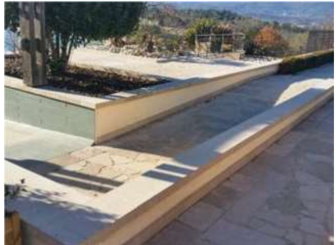
Rampe d'accès piscine
