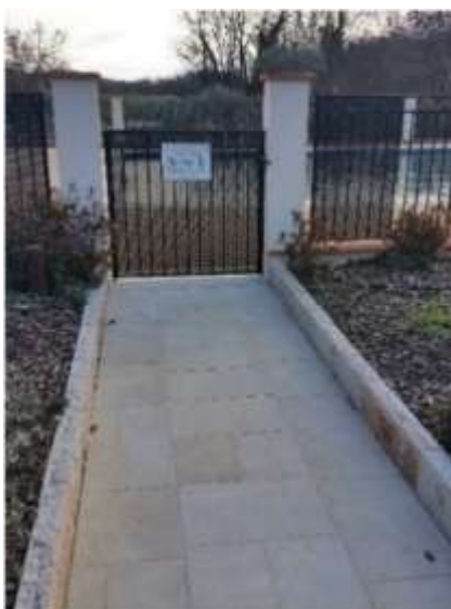
Accès plage piscine
