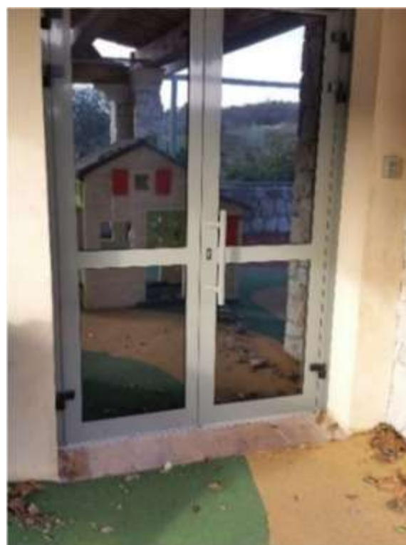
Accès cour couverte 2 unités de passage
