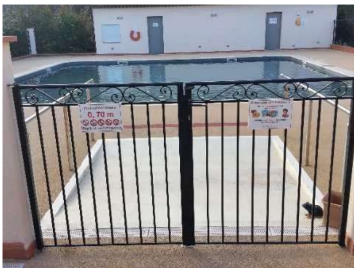
Accès piscine 2 unités de passage
