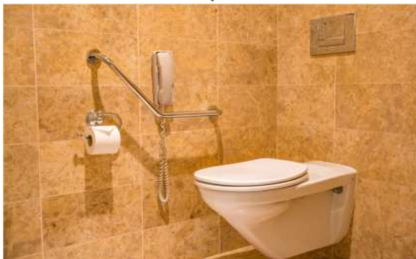
Sanitaires et salle de douche aménagés PMR Miroir incliné
